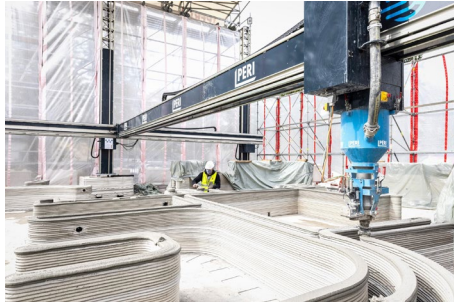
Bild 1: Im nordrheinwestfälischen Beckum entsteht Deutschlands erstes Wohnhaus im innovativen 3D-Betondruck. Beheizt, gekühlt und belüftet wird es nach seiner Fertigstellung mit hocheffizienten Energielösungen von Viessmann. (Bild: PERI GmbH)
